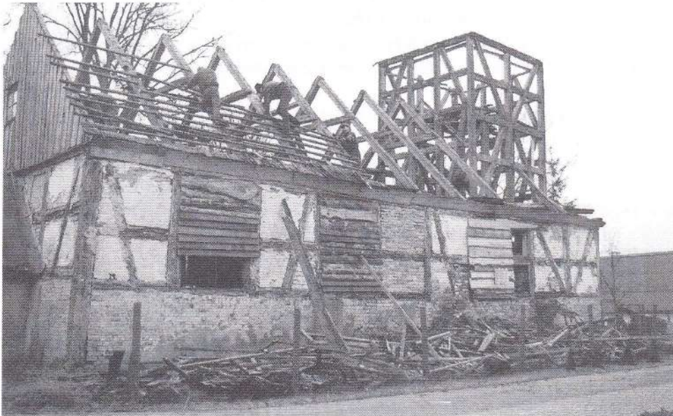
9. Bożepole Wielkie, rozbiórka kościoła, widok północno-wschodni; fot. M. Hawryszków, grudzień 2004 r.
