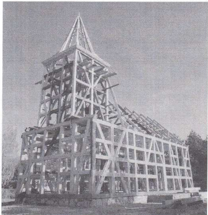
12. Wdzydze Kiszewskie, montaż dzwonnicy ustawionej na konstrukcji stropu nad zachodnią częścią kościoła, widok północno-wschodni; fot. M. Hawryszków, październik 2009 r.
