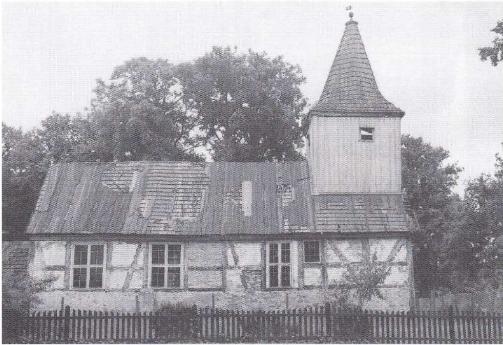
5. Bożepole Wielkie, dawny kościół protestancki wybudowany w 1659 r., dzwonnica z 1743 r., elewacja północna; fot. M. Hawryszków, lipiec 2002 r.
