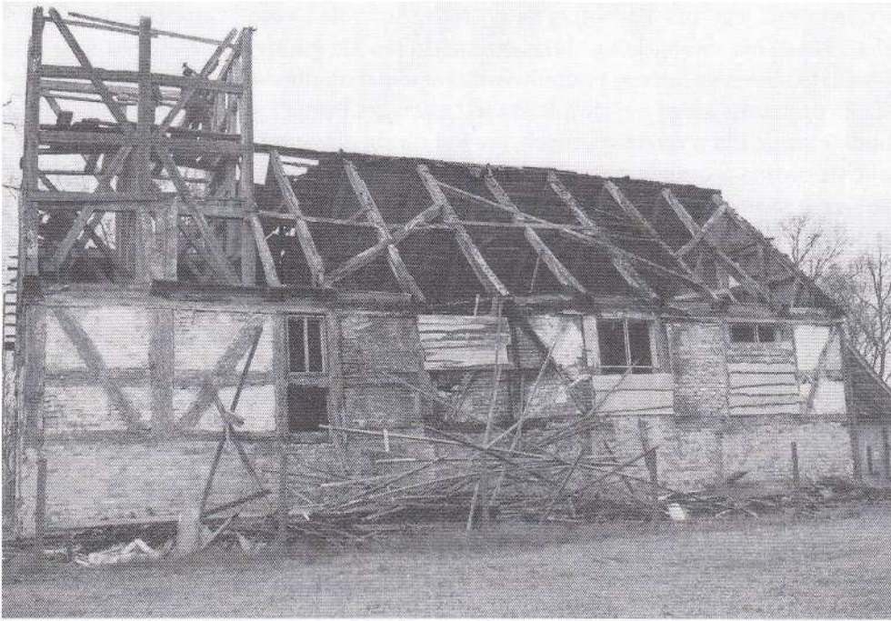
8. Bożepole Wielkie, rozbiórka kościoła, widok południowy; fot. M. Hawryszków, grudzień 2004 r.
