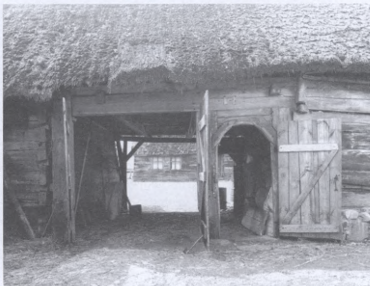
Czarna Dąbrowa; przejazd w budynku bramy. W głębi dworek. Fot. A. Wołosewicz, marzec 1978. Arch. M-KPE Wdzydze
