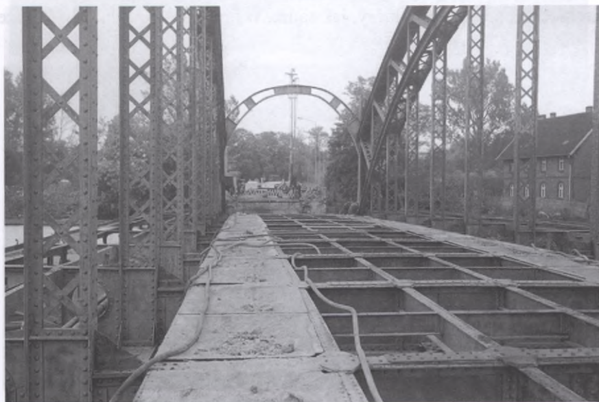
Remontowany wiadukt bytowski
