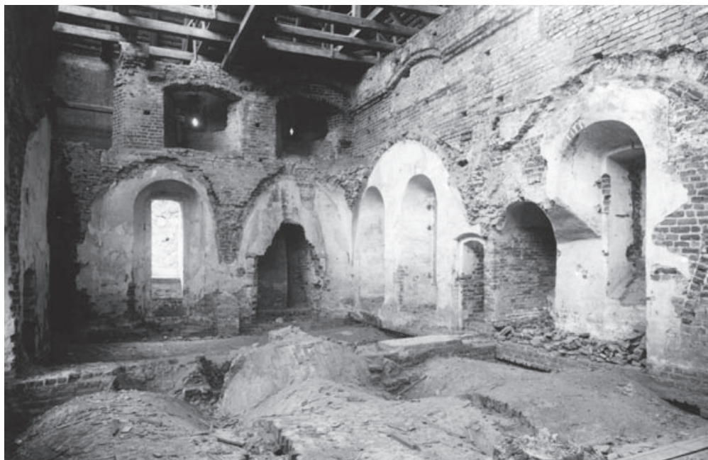
2. Wnętrze pierwszego piętra północnego skrzydła zamku. Widoczny refektarz z relikwiami kominka, który posiadał dekorację malarską. Stan w latach 30. XX w.
