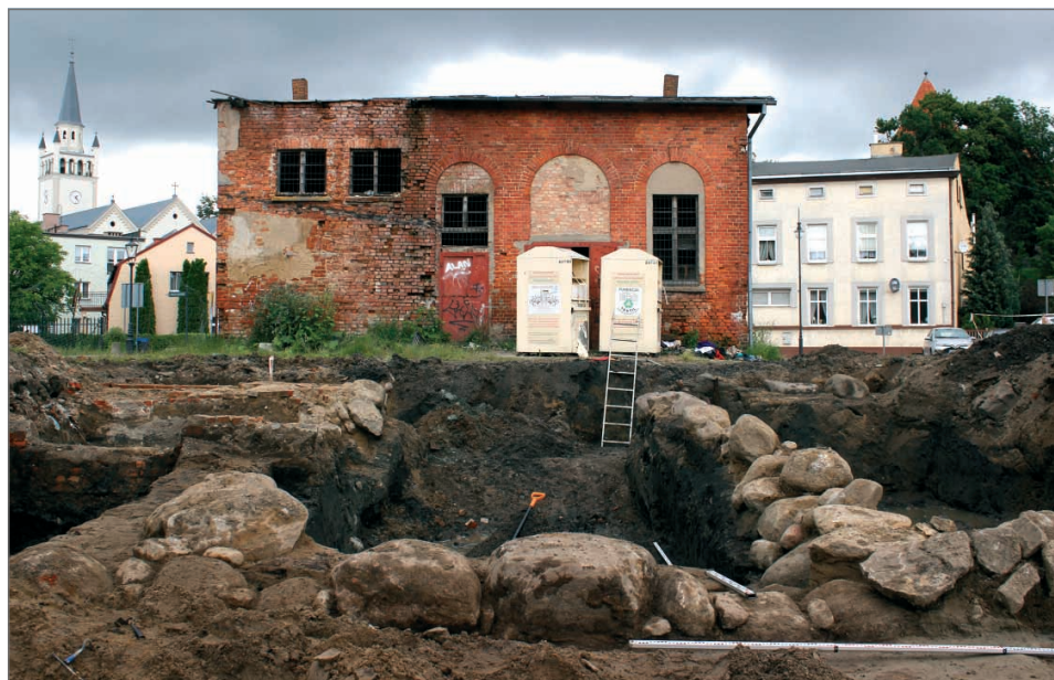
2. Ceglany budynek poddany rozbiórce – domniemana kaplica protestancka, przekształcona w okresie powojennym w warsztat rzemieślniczy. Fot. P. Szczepanik.
