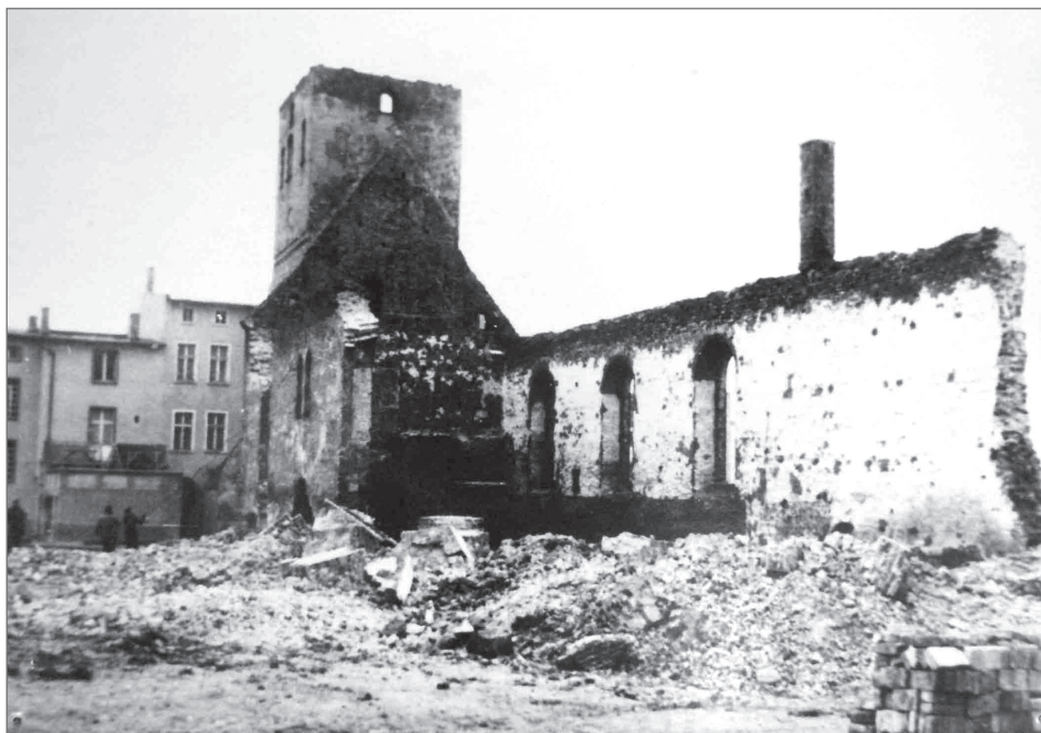
Fot. 2. Rozbiórka wypalonej nawy kościoła św. Katarzyny w Bytowie, autor nieznanym, Archiwum Muzeum Zachodniokaszubskiego w Bytowie
