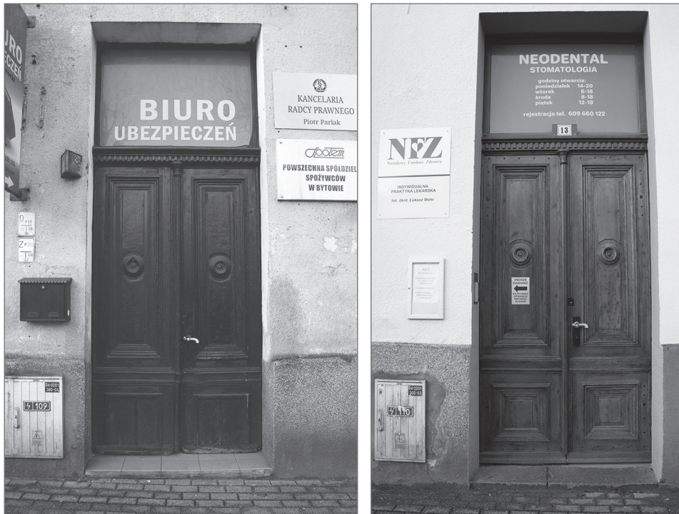
il. 18. Widok awersów drzwi zewnętrznych holu – południowego i północnego (fot. A. Jasiulewicz 2020).
