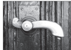
il. 12. Przykładowe detale awersu drzwi zewnętrznych południowego holu kamienicy przy ul. Wojska Polskiego 11, fot. N. Wałdoch 2017.
