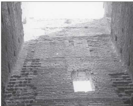
Fot. 7. Wschodnia ściana wieży, widok od strony wnętrza. W górnej strefie widoczne elementy szczytu schodkowego, niżej strzępiał, fot. D. Ptaszyńska, 1959, WUOZ Słupsk
