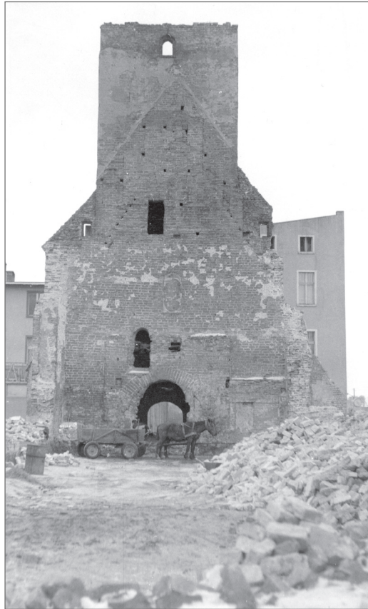
Fot. 8. Wschodnia ściana wieży, widok od strony nawy po wyburzeniu ścian kościoła. W górnej strefie czytelny zarys szczytu schodkowego, fot. D. Ptaszyńska, 1964, WUOZ Słupsk
