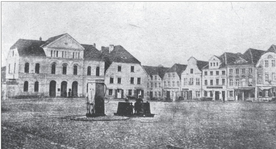
Ryc. 2. Przedwojenna fotografia bytowskiego rynku, widok na obszar poddany pracom wykopaliskowym w roku 2011 (wg G. Bronisch, W. Ohle, H. Teichmüller, Kreis Bütow , Stettin, 1939, tabl. XI)
