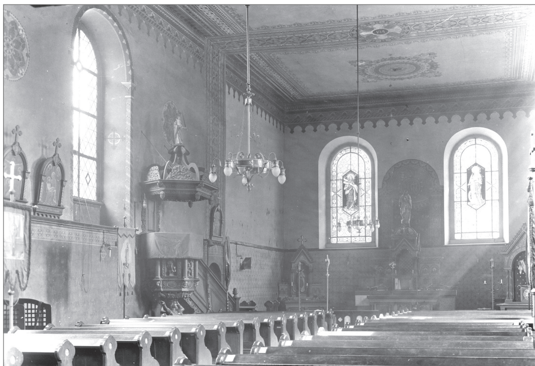
Fot. 15. Wnętrze kościoła św. Katarzyny, lata 30. XX w., WUOZ Słupsk
