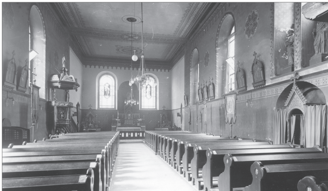
Fot. 14. Wnętrze kościoła św. Katarzyny, lata 30. XX w., WUOZ Słupsk
